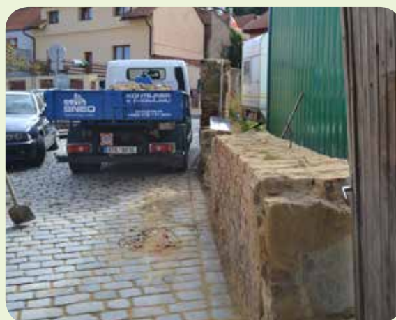
oprava oplocení pozemků v Liboci
