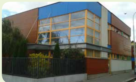
ZŠ T. G. Masaryka - obj. Bělohorská 174 výměna dřevěného obložení fasády a oprava oken
