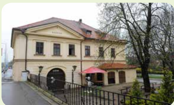
KC Kaštan Bělohorská 201/150, oprava krovu
